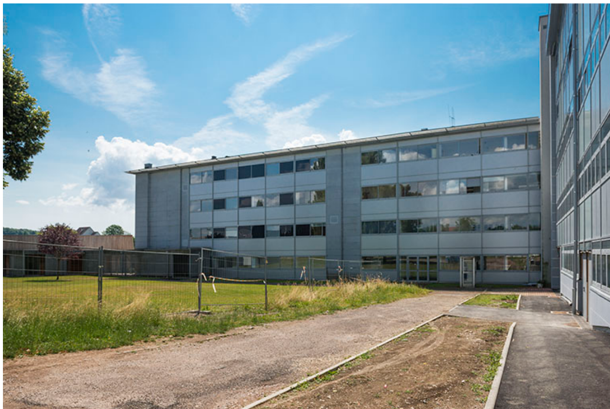
Façade septentrionale de l'internat-externat.
