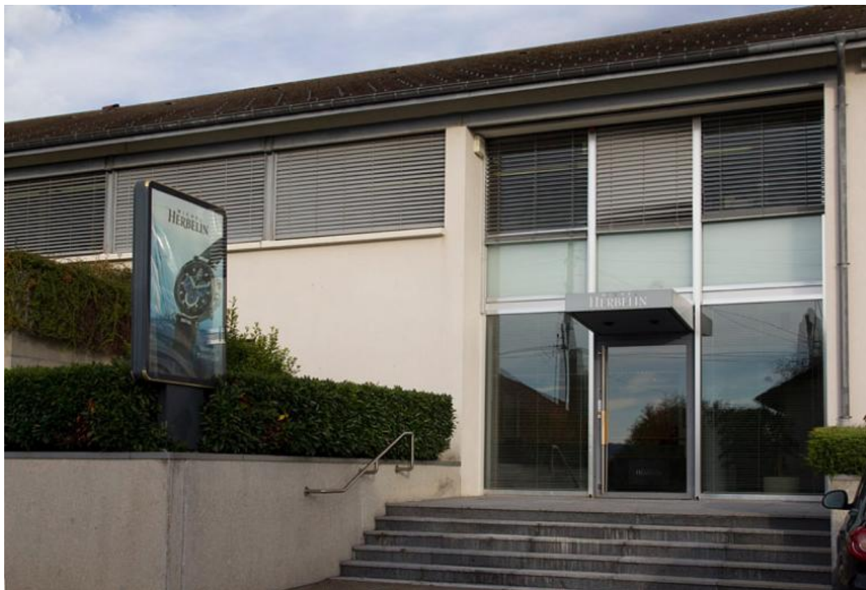
Entrée de l'usine.
