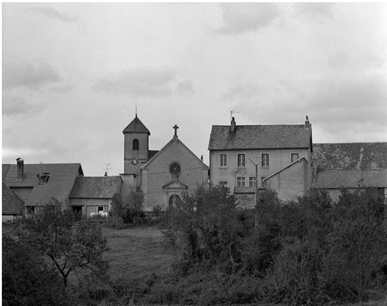
Eglise paroissiale Saint-Marcellin.
