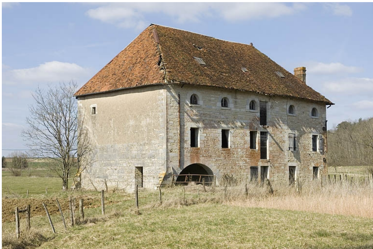
Vue depuis le sud.
