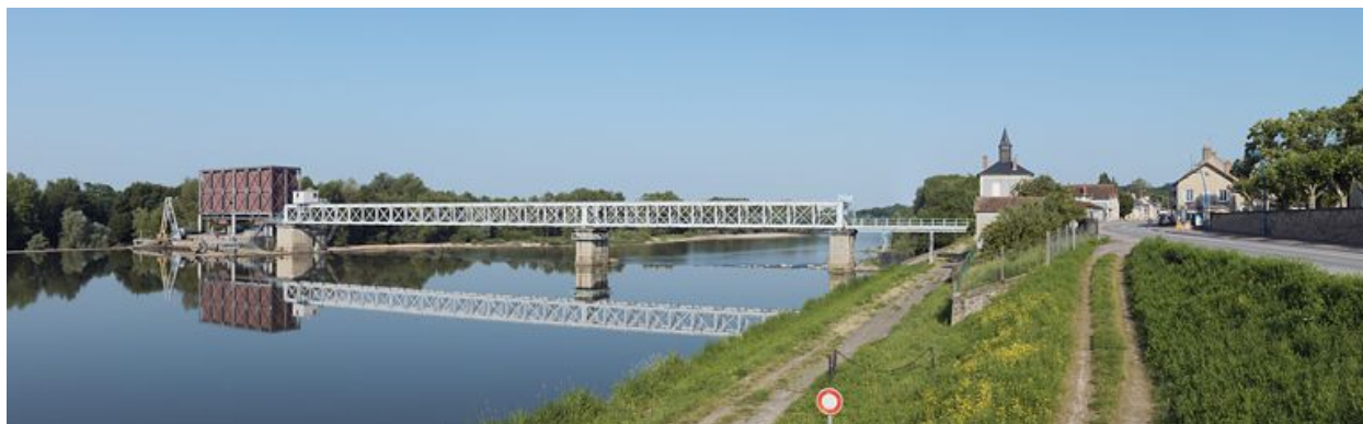
Vue d'ensemble du barrage.
