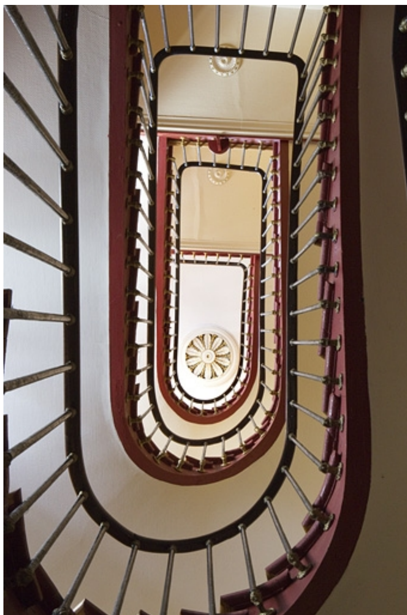
Vue d'ensemble de l'escalier depuis le rez-de-chaussée.
