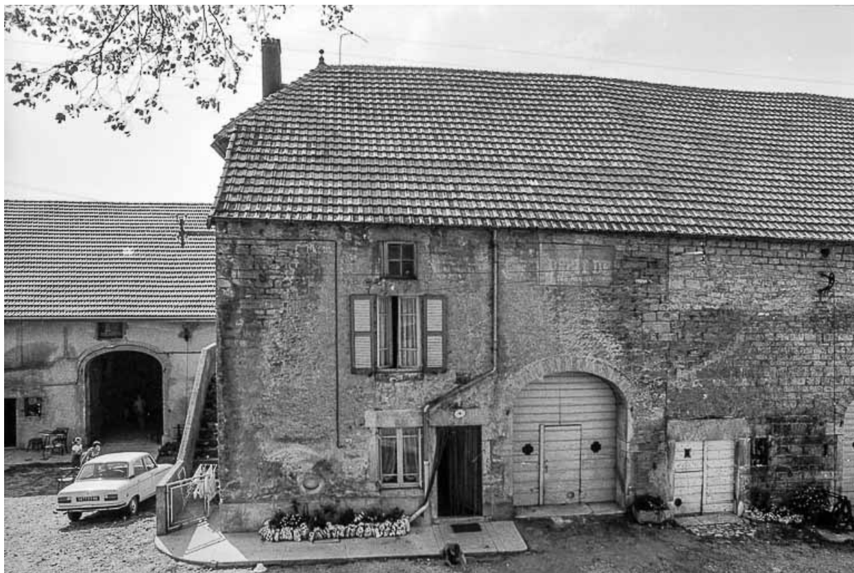
Ferme cadastrée D2 193 : façade antérieure.
