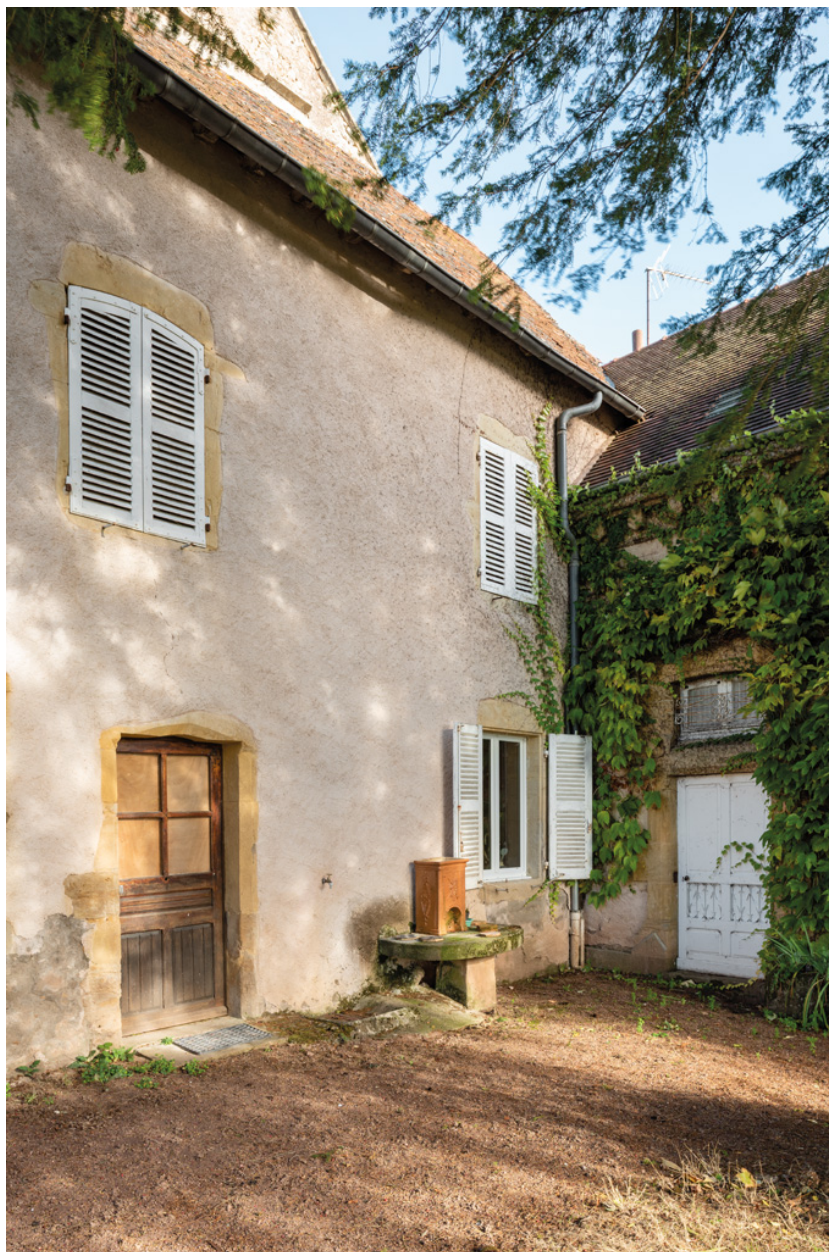
Façade de l'aile sud du logis.
