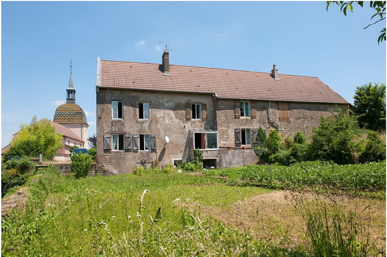
Vue générale de la façade postérieure.
