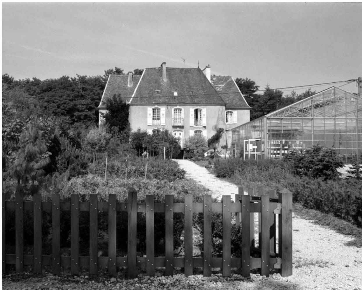
Vue d'ensemble de face depuis la rue.
