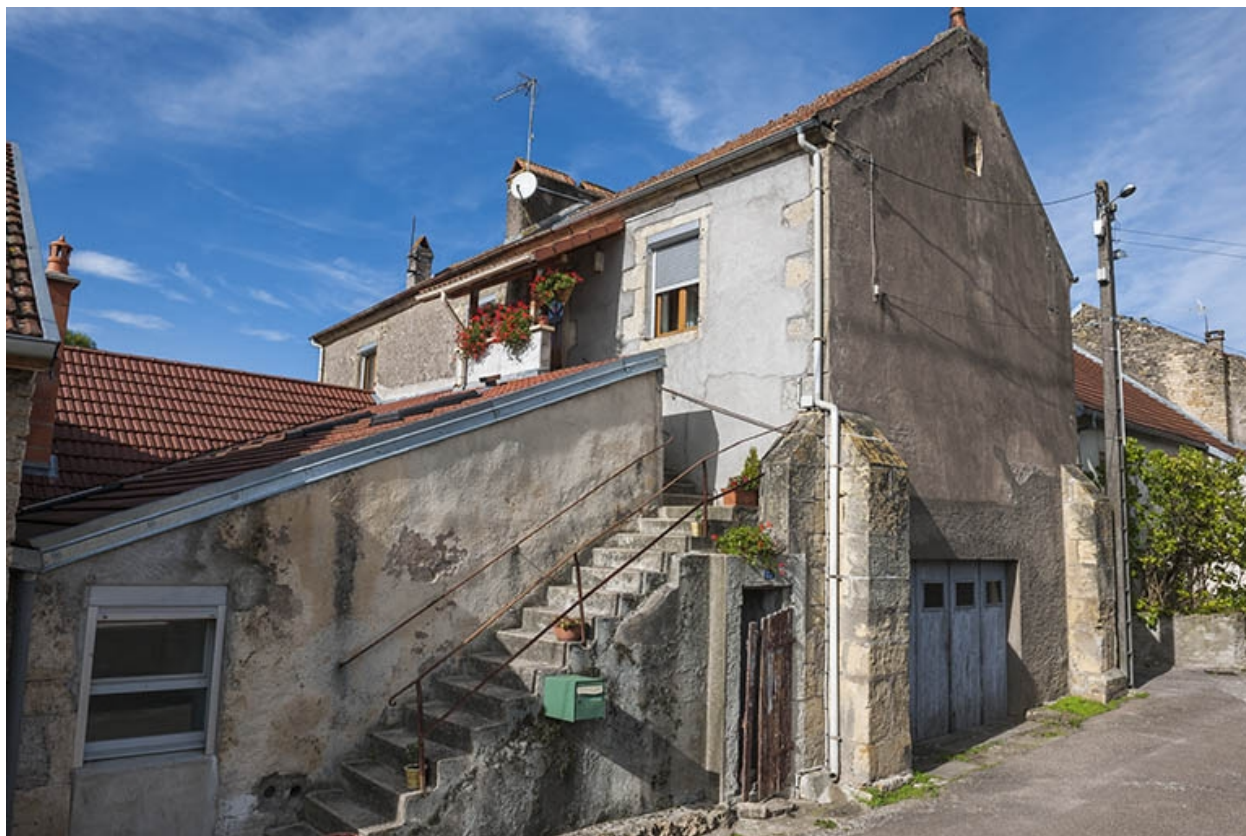
Vue générale depuis la rue des Ruaux.
