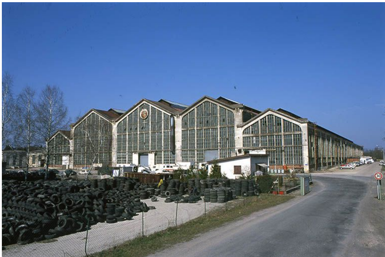
Elévation sud-ouest de la grande halle.
