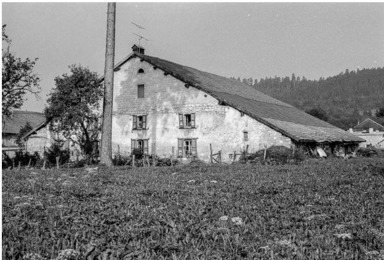
Ferme : façades antérieure et latérale droite.
