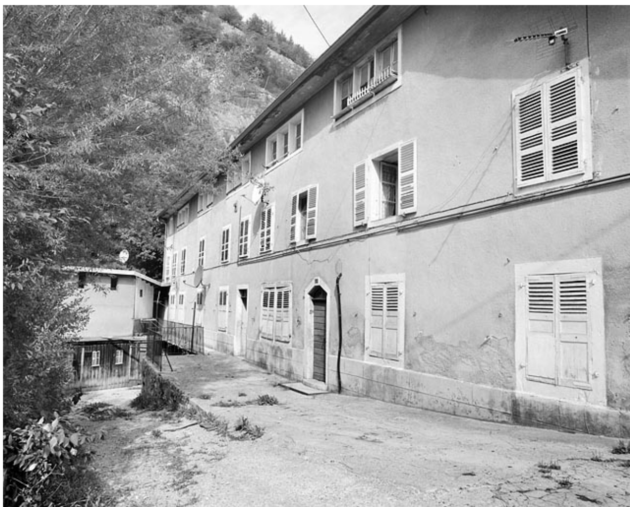
Façade principale, de trois quarts droite.
