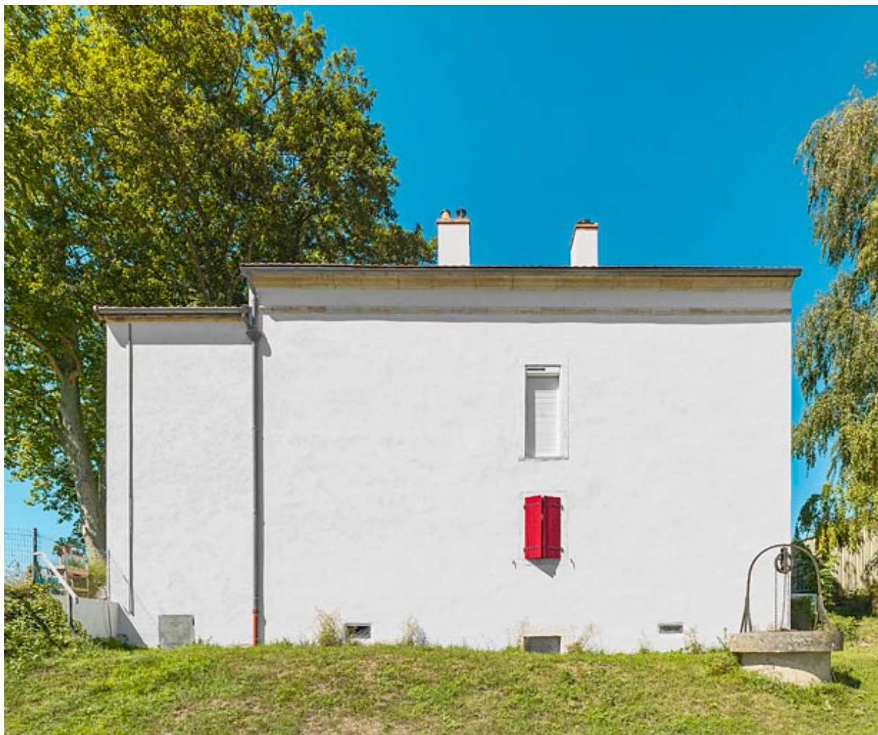
La maison éclésièr : face arrière.
