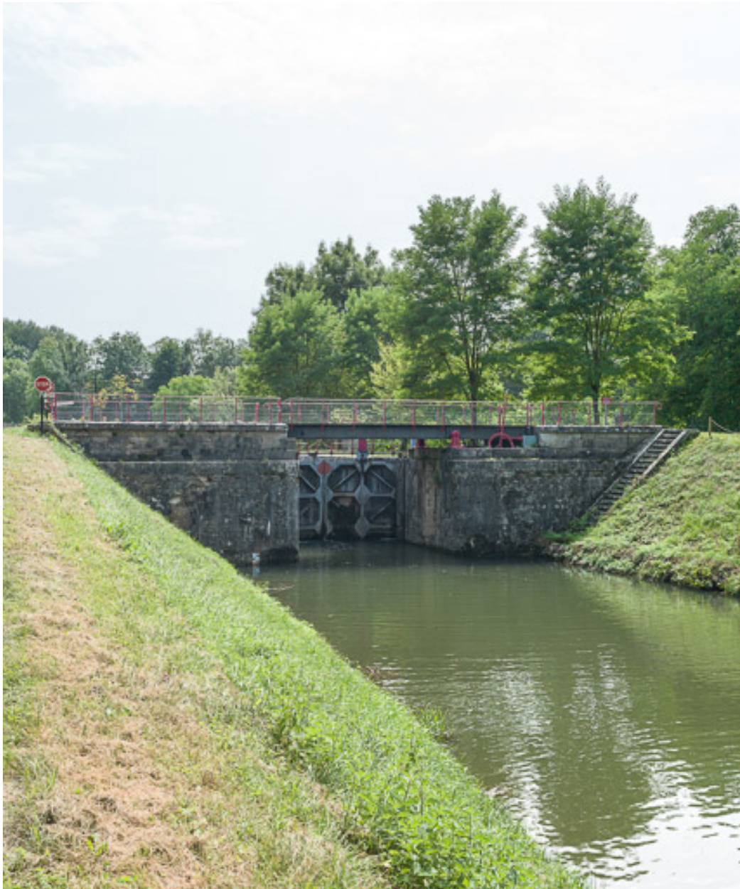
Vue du pont.
