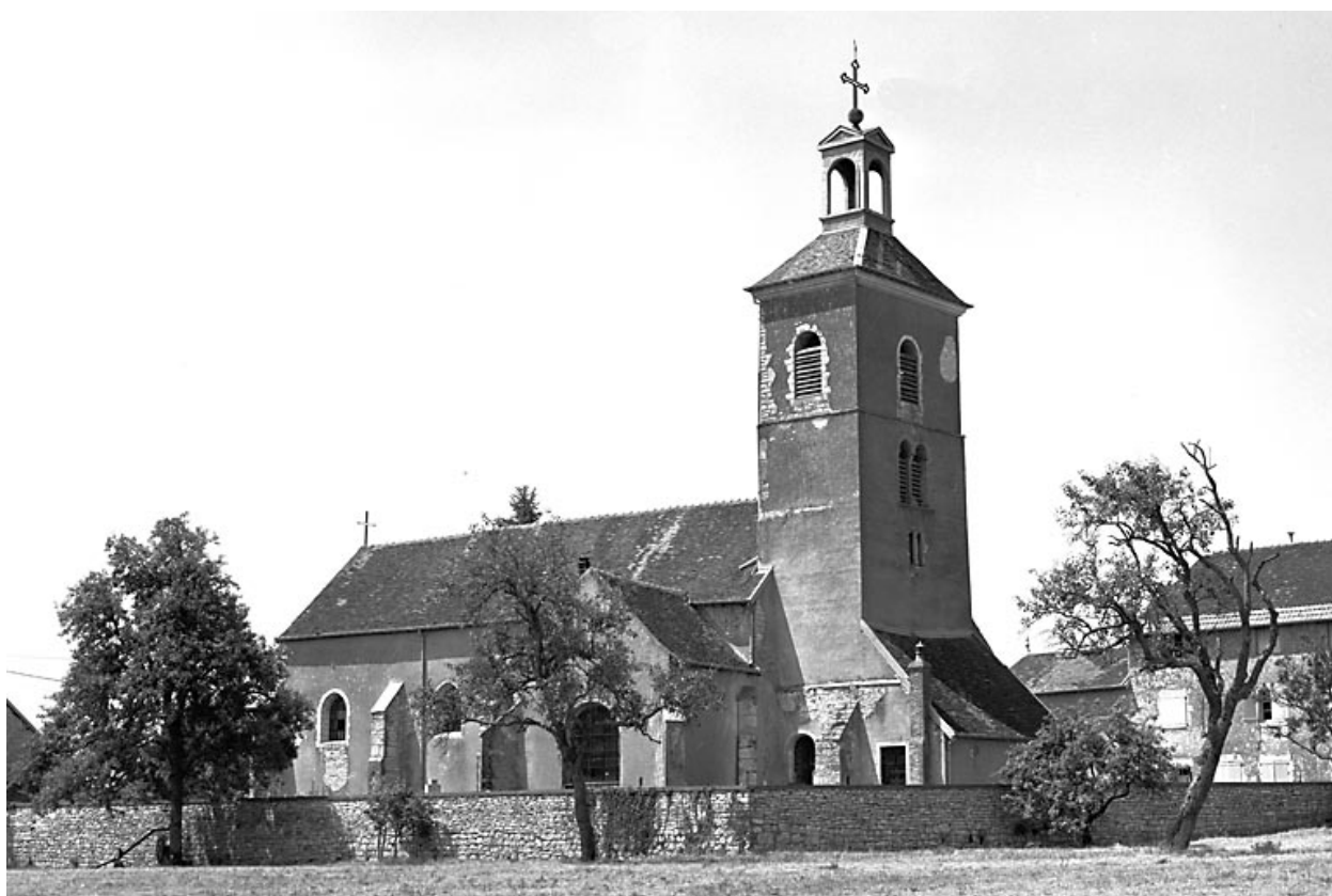
Façade latérale sud.
