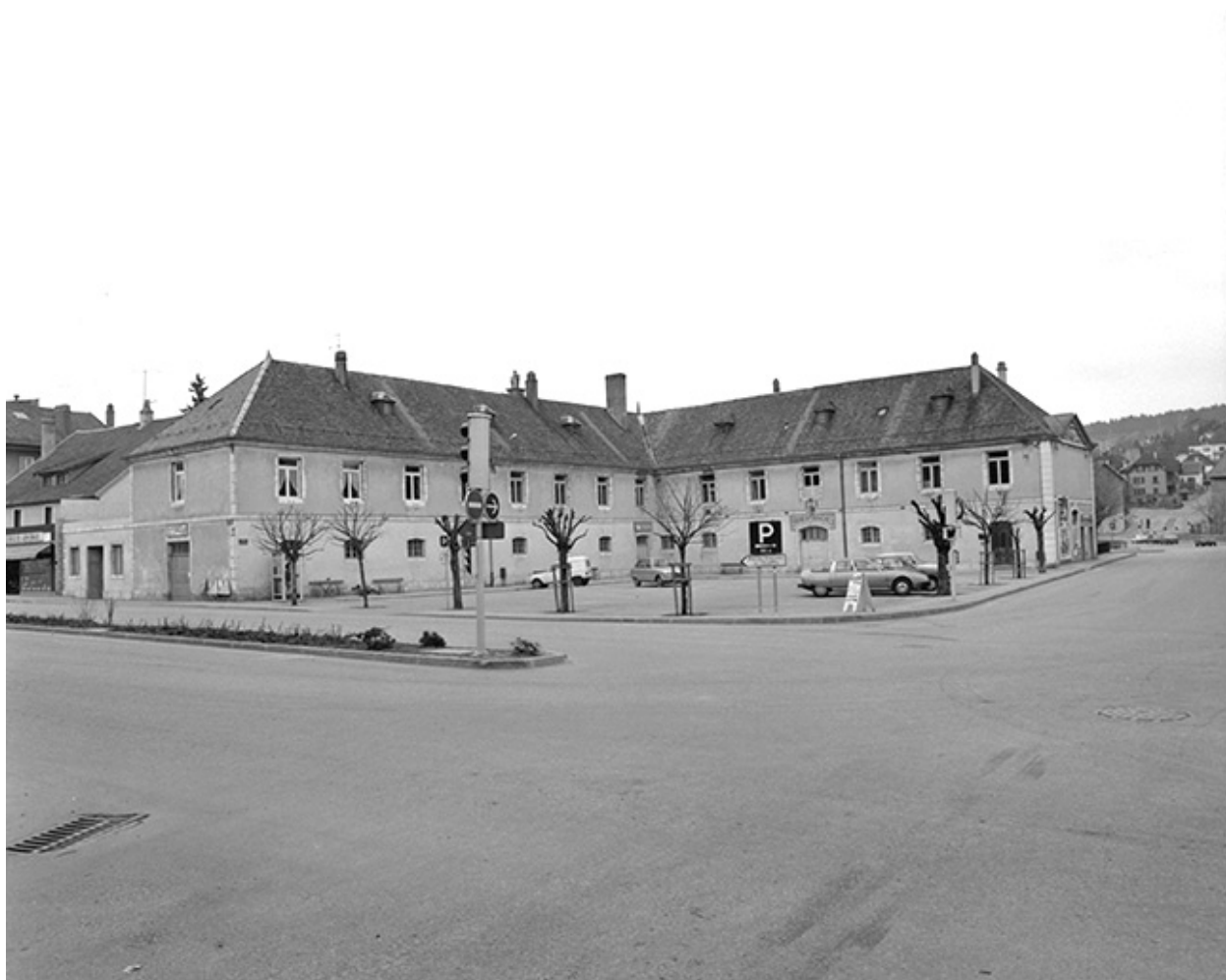
Corps de bâtiment gauche.
