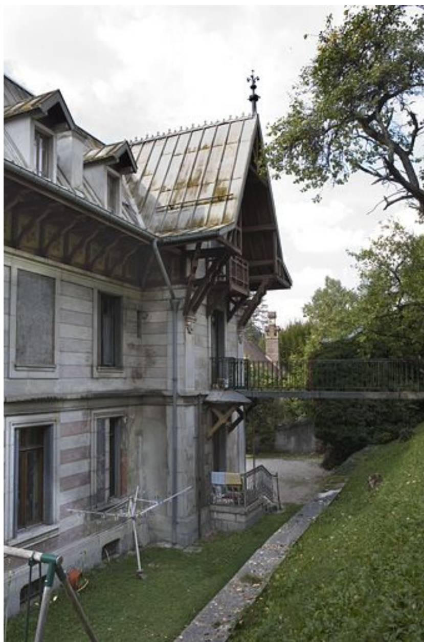
Elévation postérieure, de trois quarts gauche.
