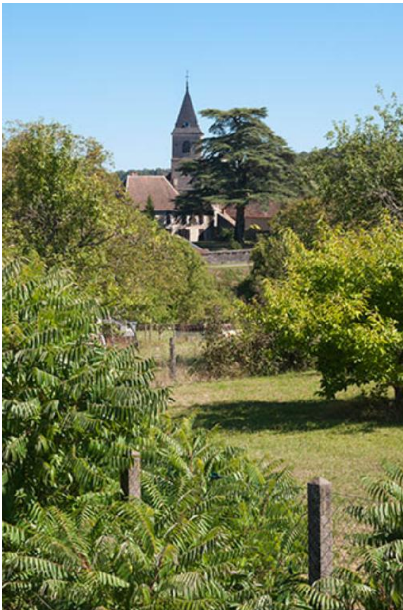
L'église et le château, vue ouest
