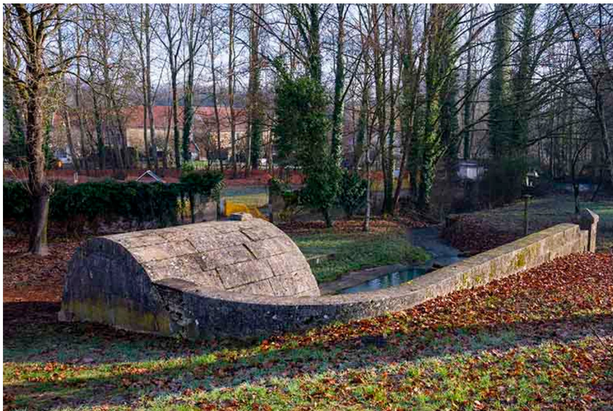
Mur de soutènement, vue depuis le nord.
