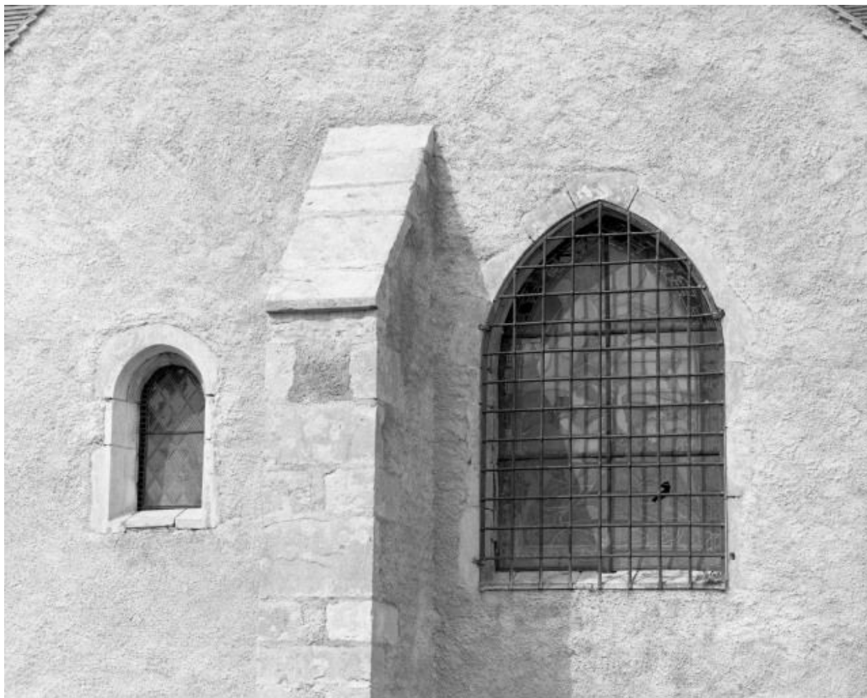
Chapelle latérale droite, baies
