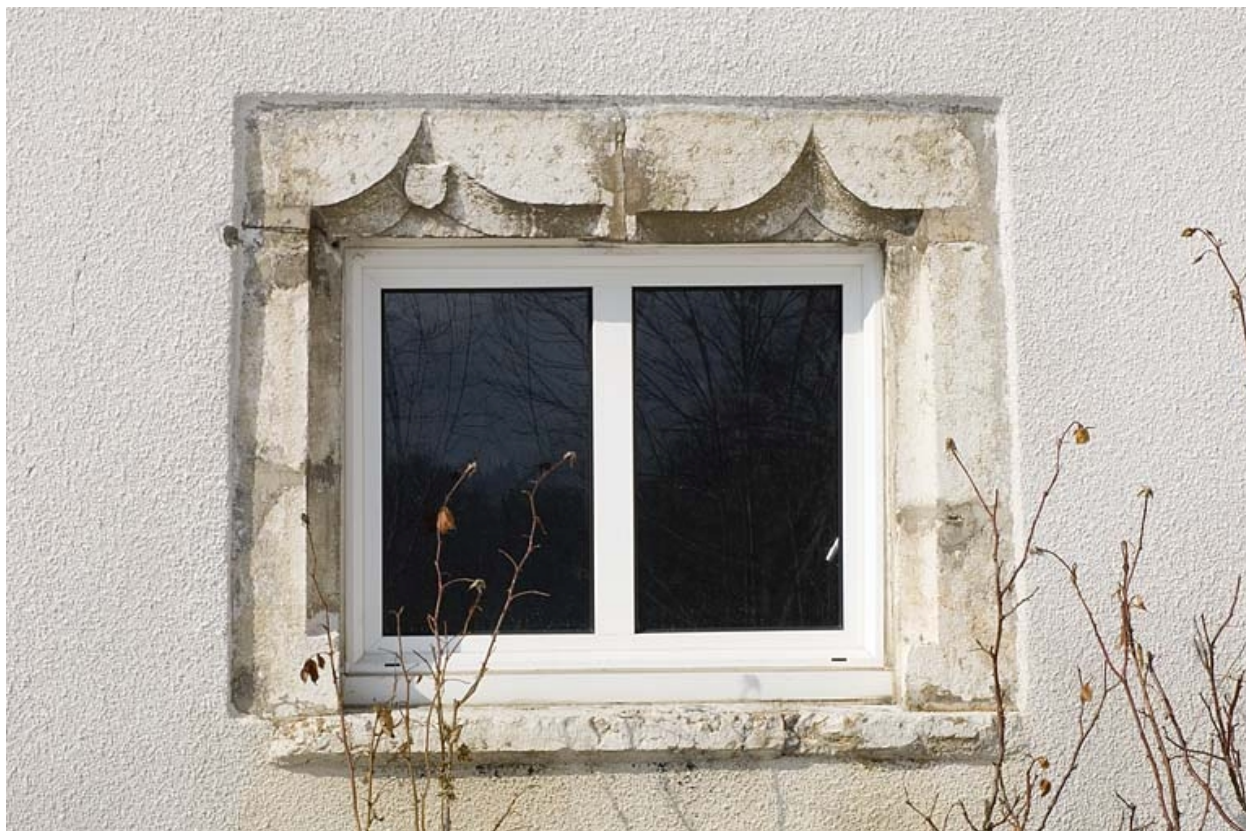
Ferme à Entre-les-Fourgs : baie du 16e siècle.
