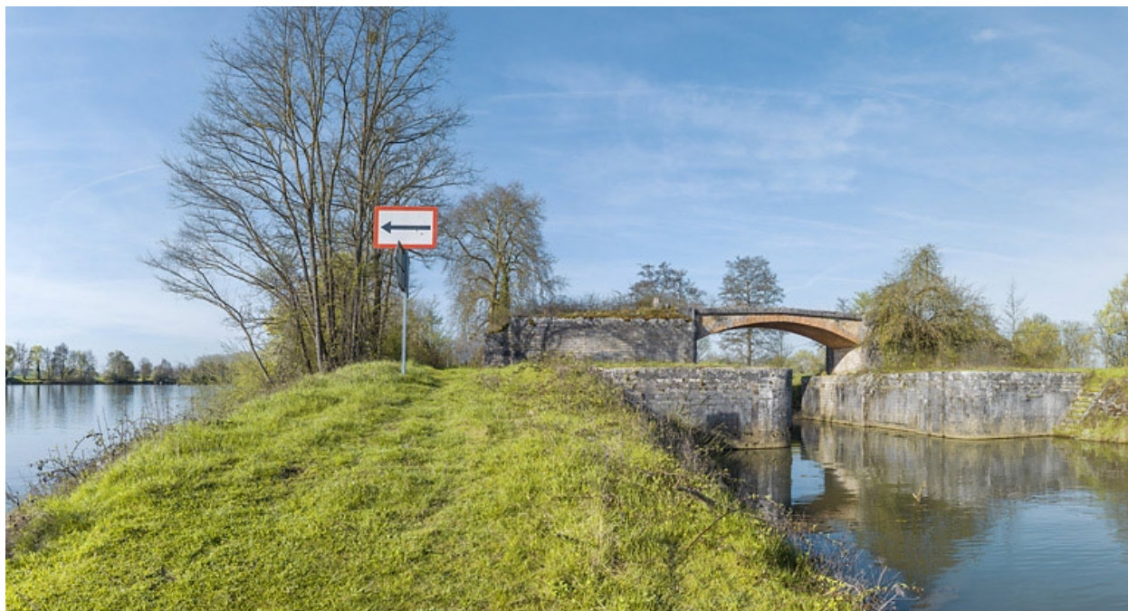
L'entrée de l'ancienne dérivation, rive droite.
