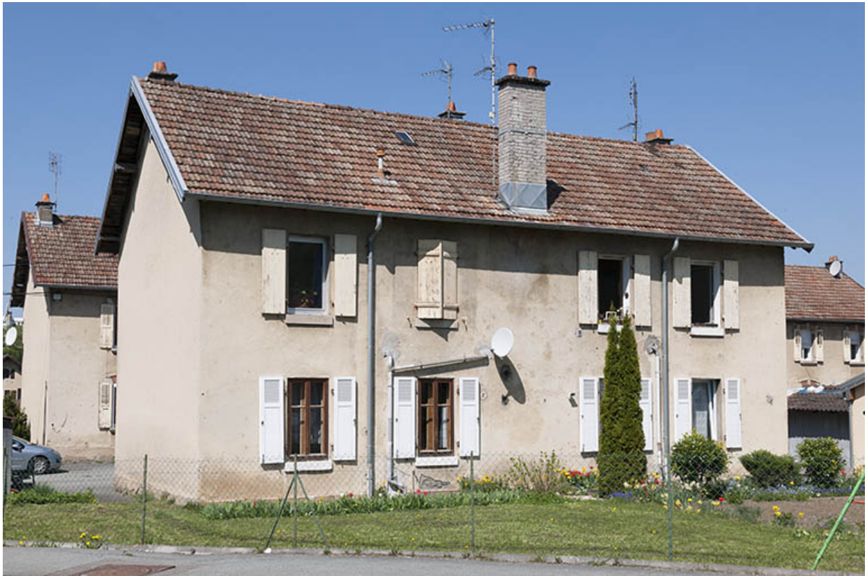
Façade postérieure d'une habitation.
