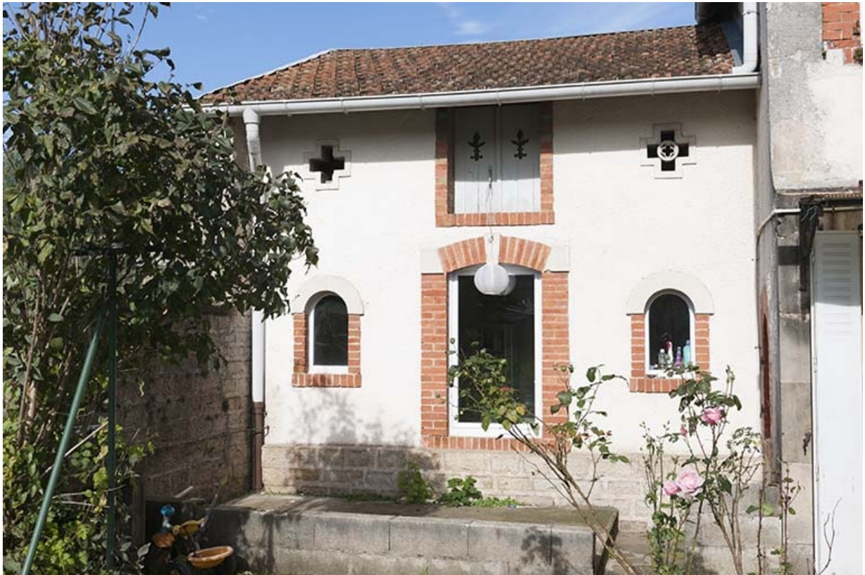
Façade antérieure de la remise.
