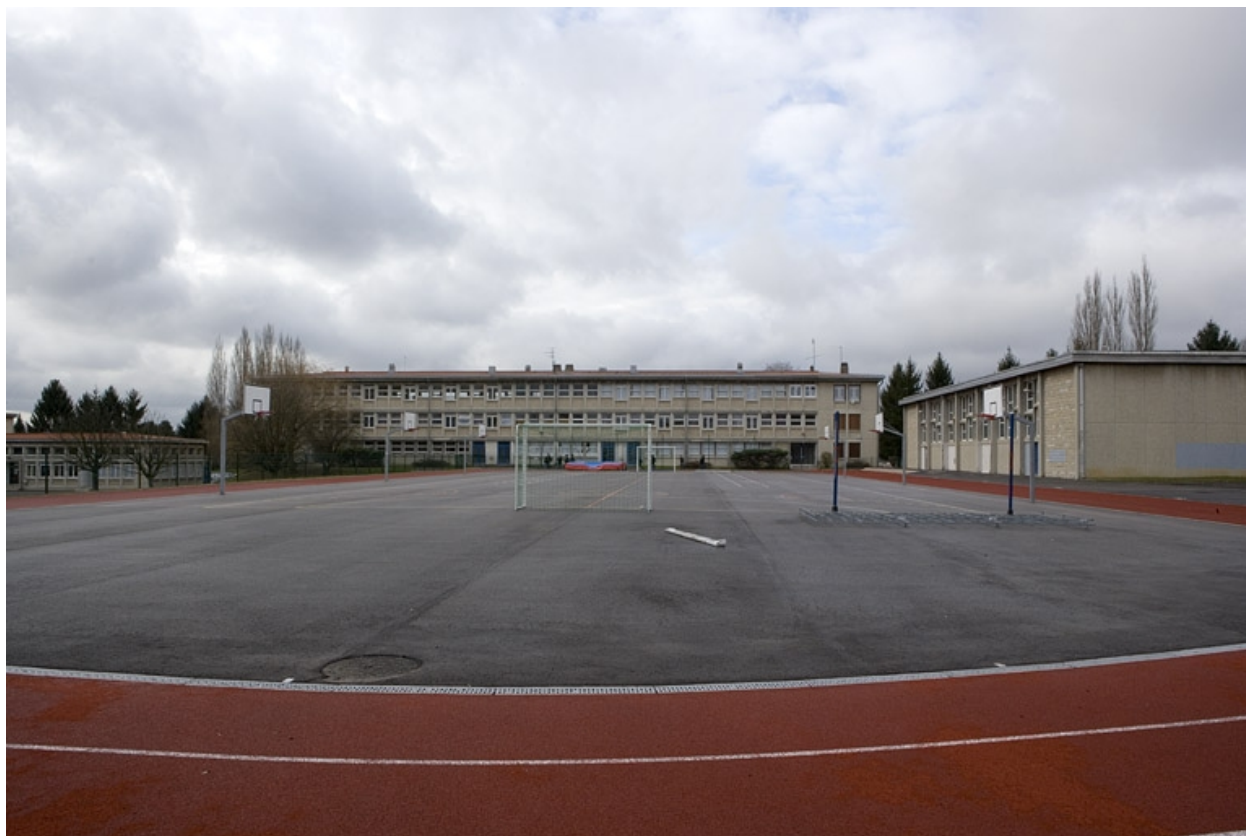
Vue d'ensemble bâtiment F2 et C.
