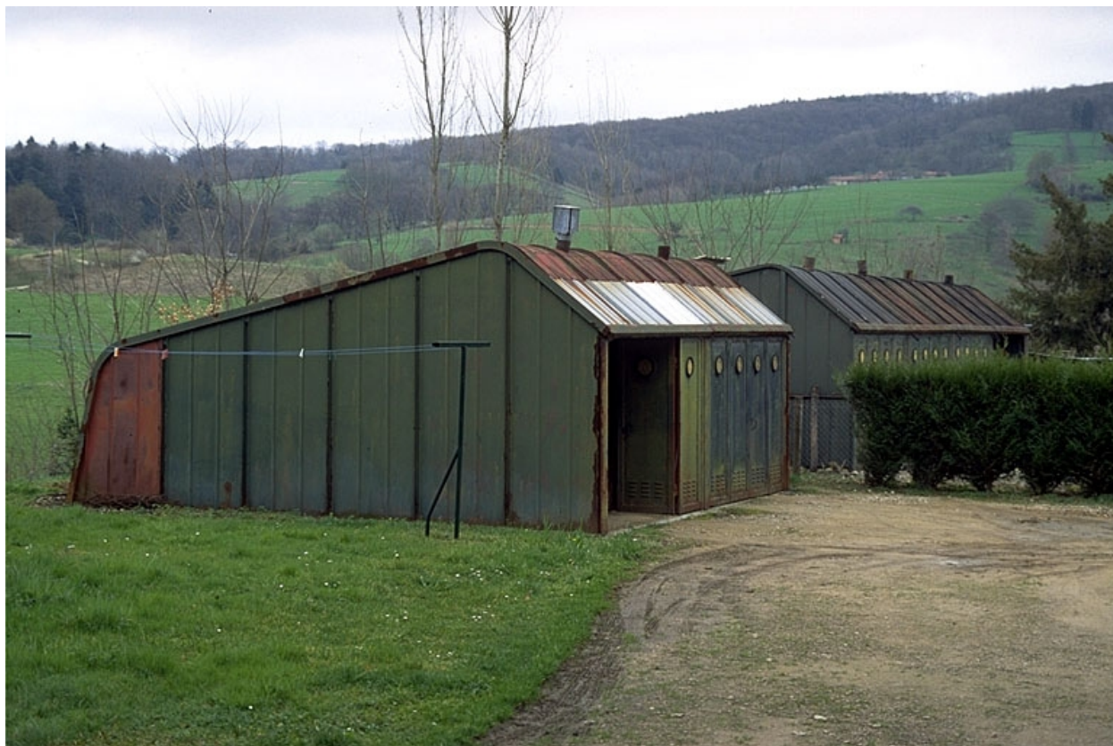
Remises d'automobile métallique : vue d'ensemble.
