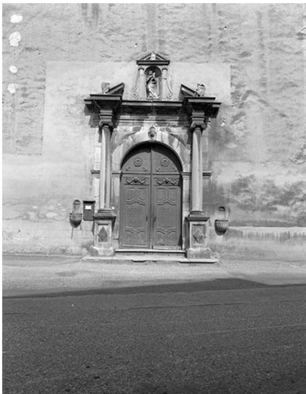
Portail de la façade antérieure : vue générale.
