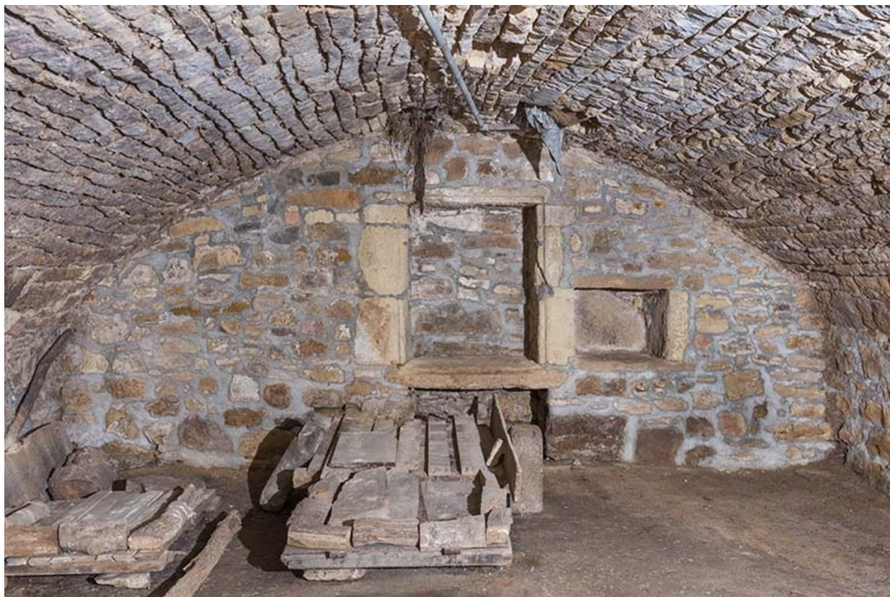
Sous-sol, depuis l'entrée.
