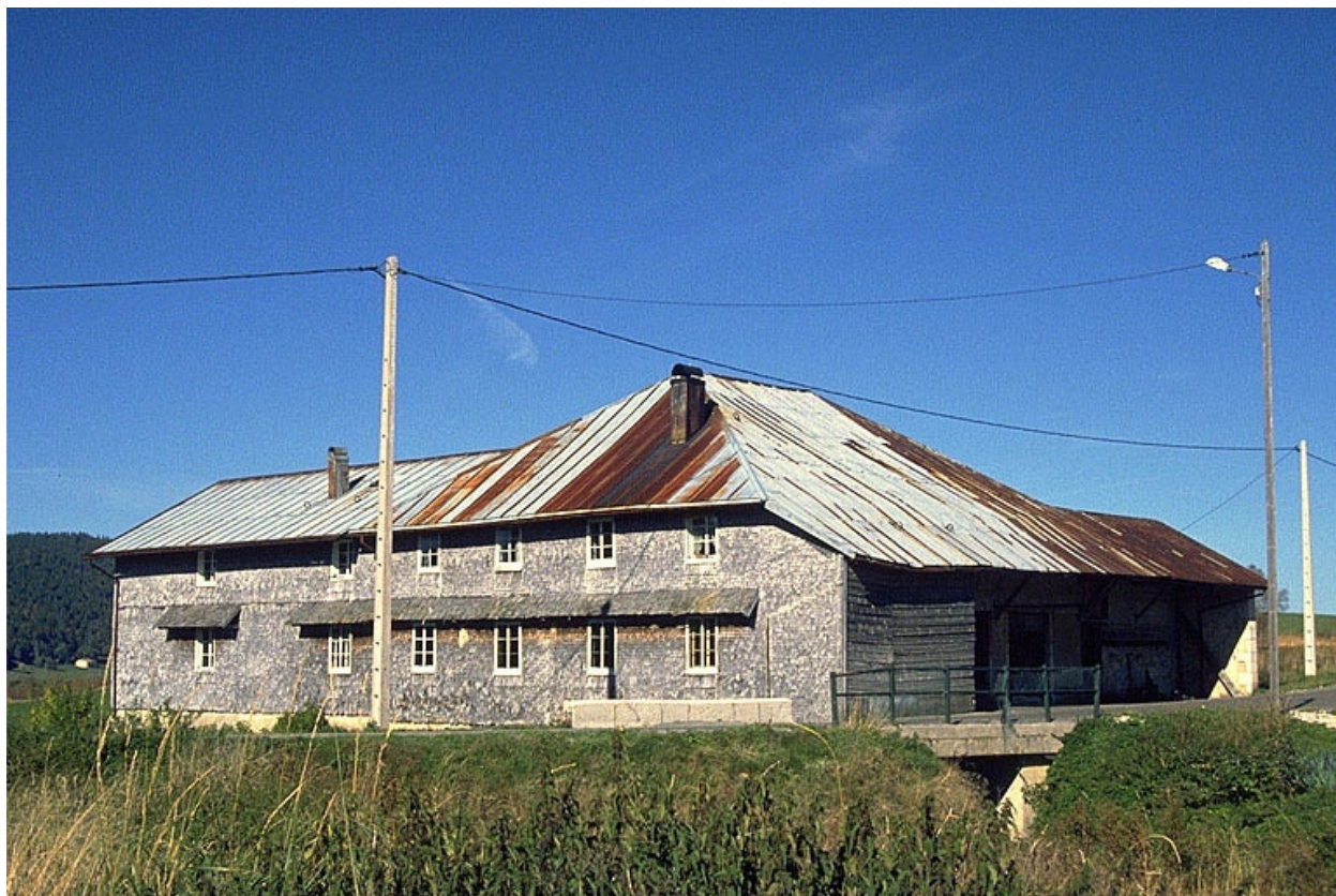
Bâtiment vu de trois quarts gauche.
