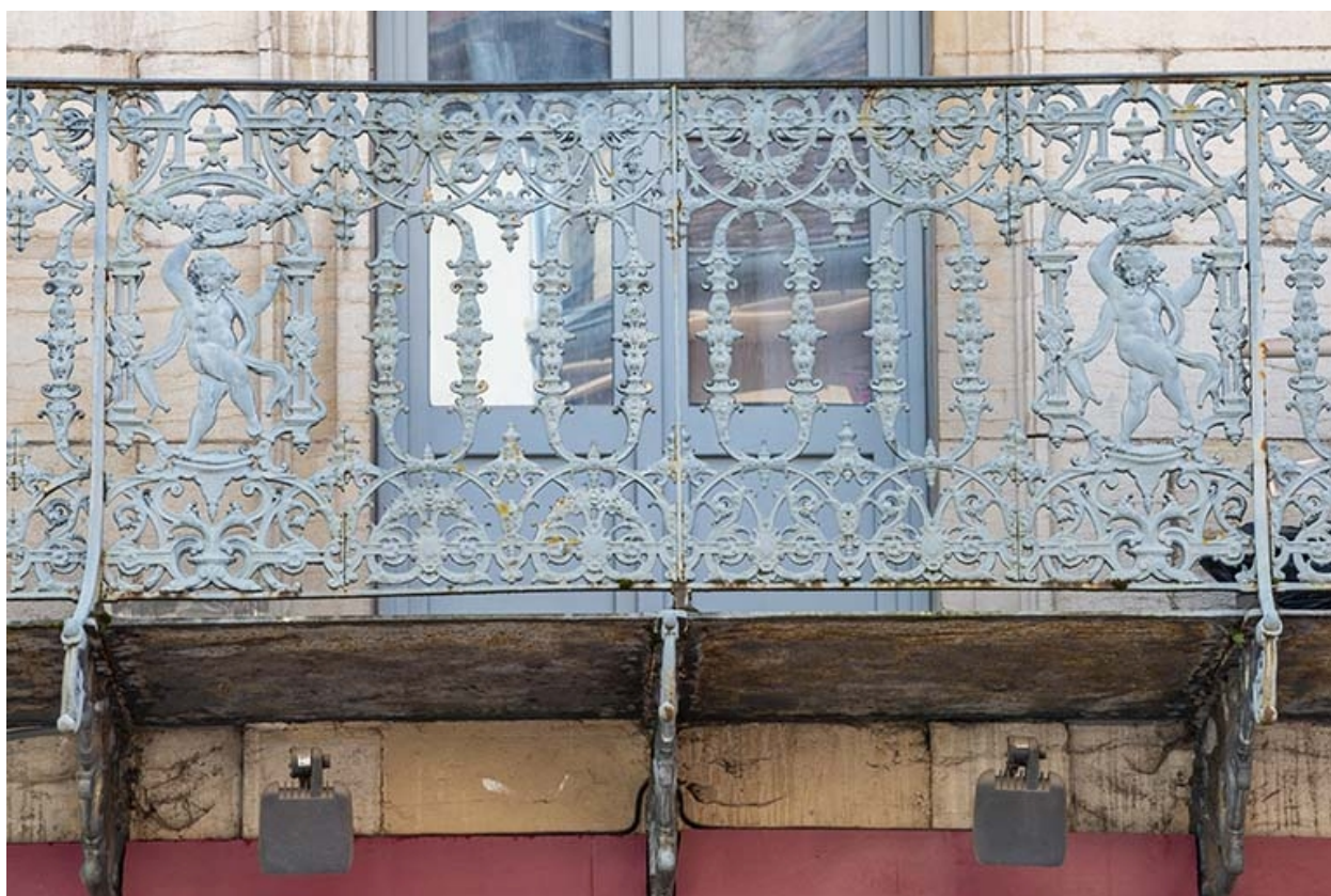
Détail du balcon du premier étage.
