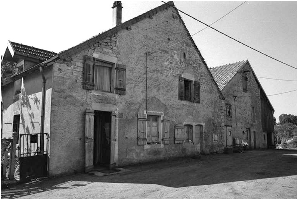
Maison située le long du chemin de grande communication n° 96 de Plasne à Mirebel.
