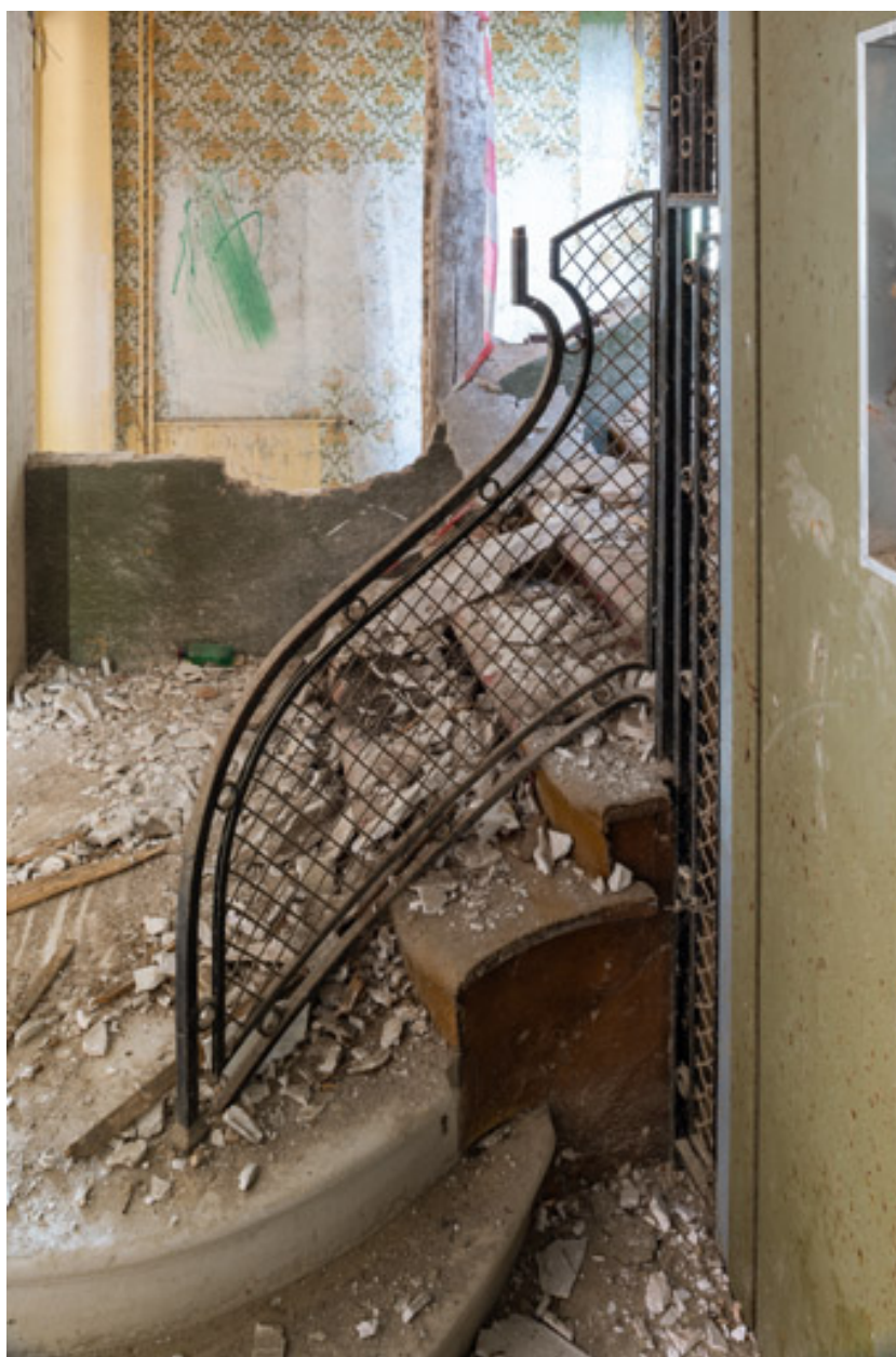
Escalier ouest, détail, rampe d'appui.
