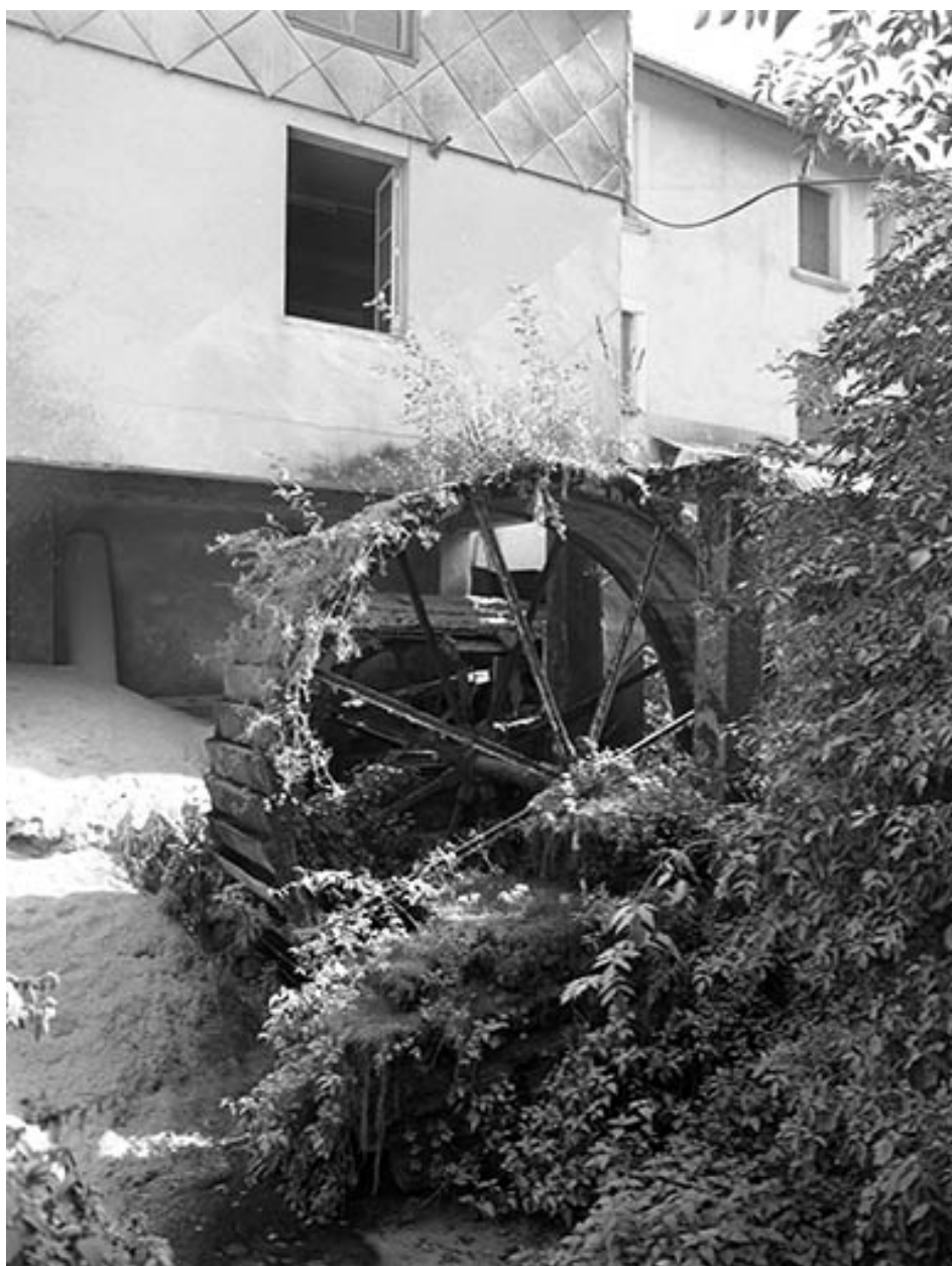
Roue hydraulique sur la façade postérieure.
