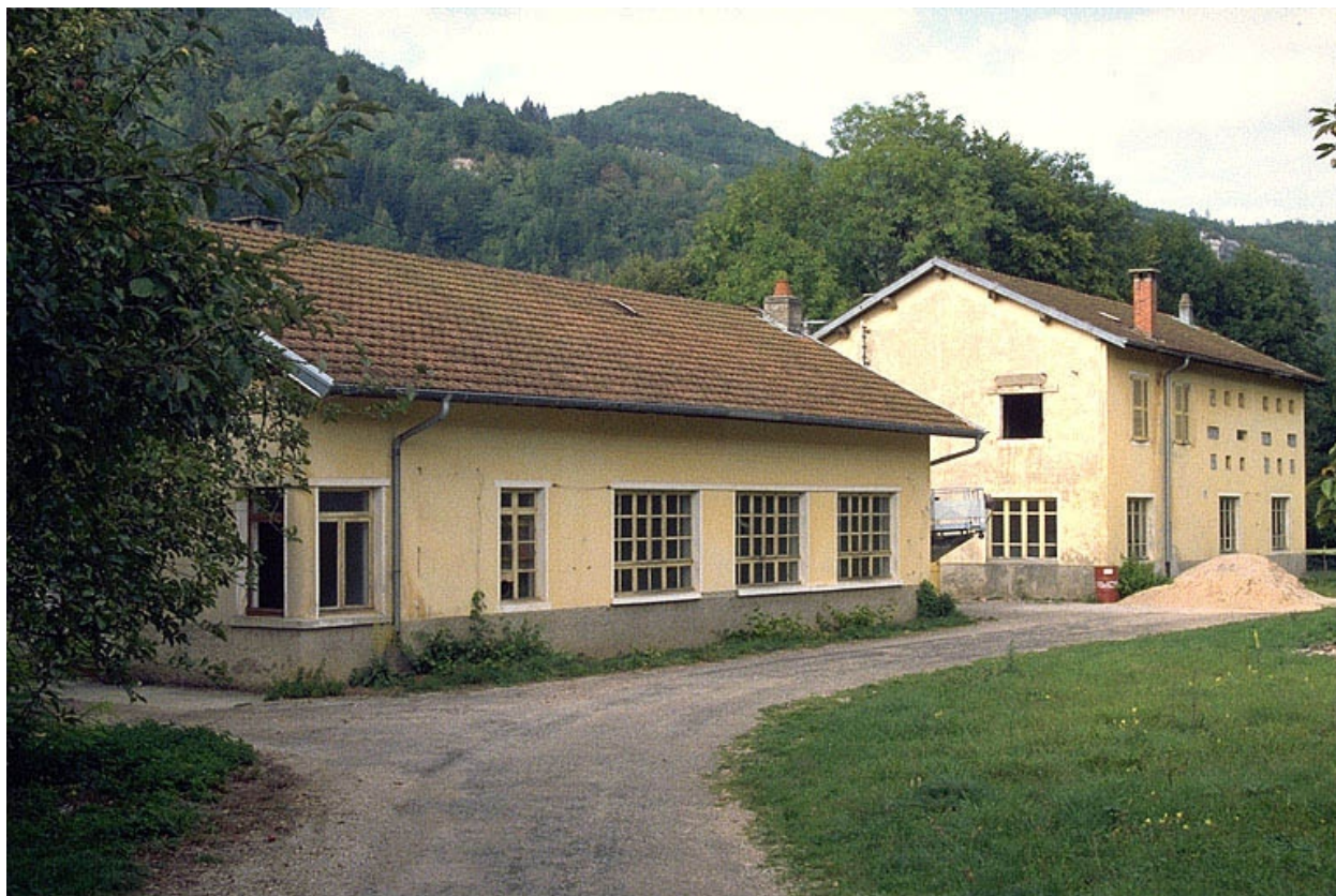
Bâtiments depuis l'entrée.
