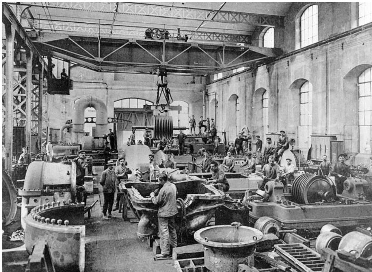
Montage des turbines à vapeur.
