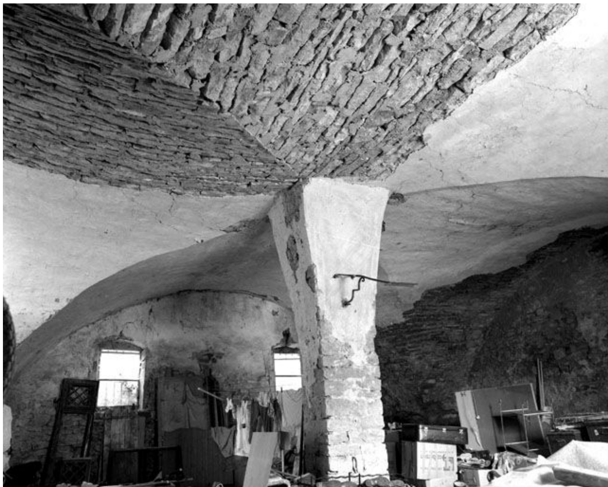
Pièce voûtée au rez-de-chaussée : la voûte.
