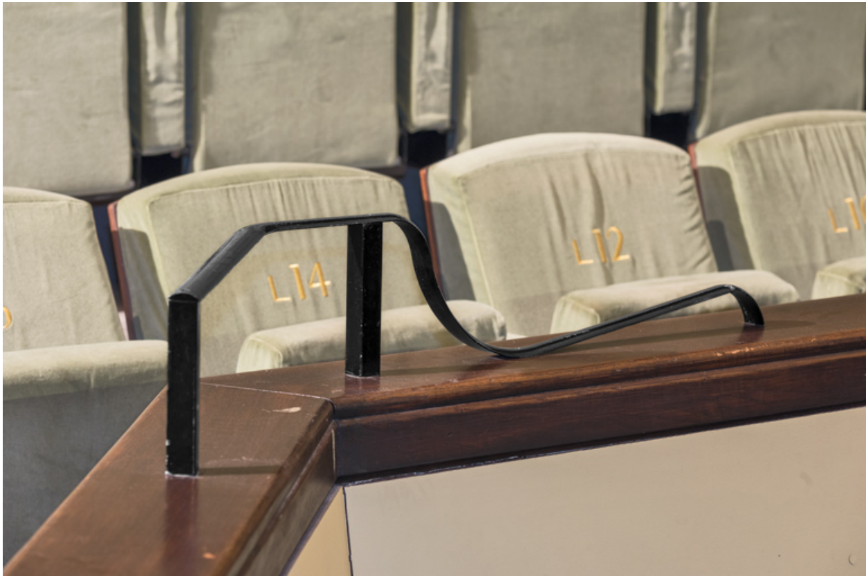
Salle, balcon : ferronnerie sur le garde-corps.
