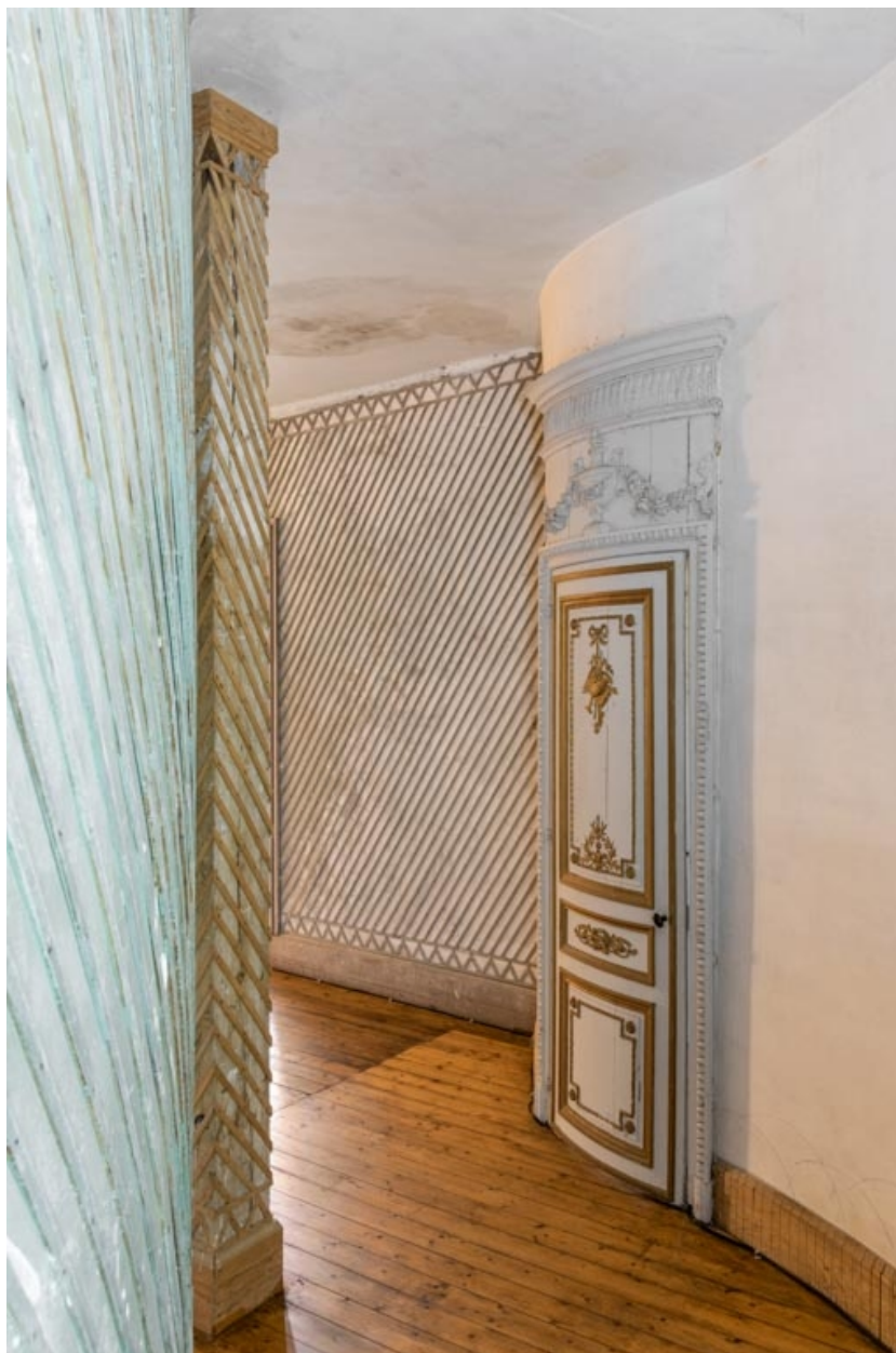
Couloir desservant la salle (à gauche).
