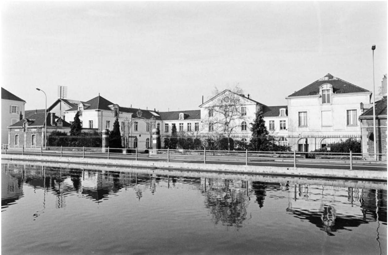
Façade antérieure des ateliers et bureaux centraux.
