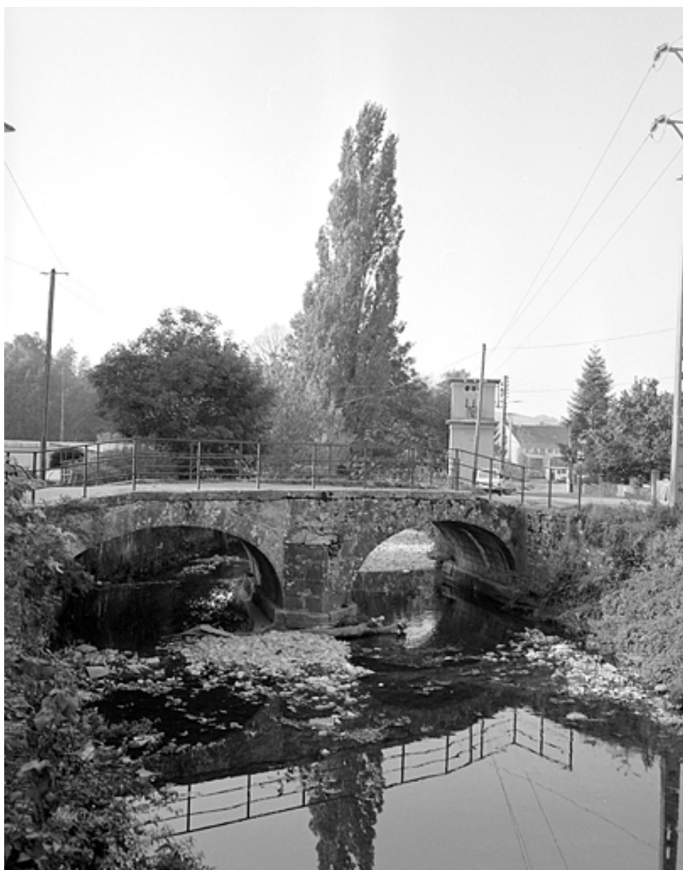
Vue du pont en amont.
