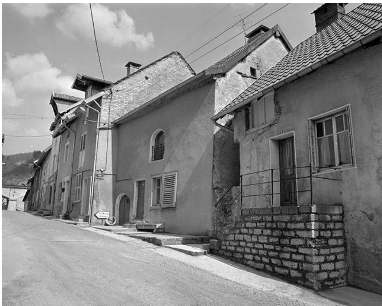
Maison de vigneron située 4 rue des Martinets.
