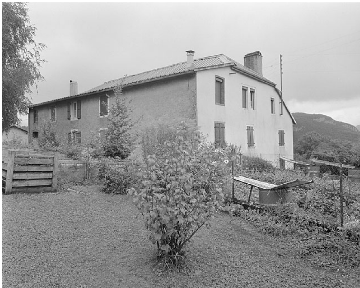
Façade postérieure et face sud.
