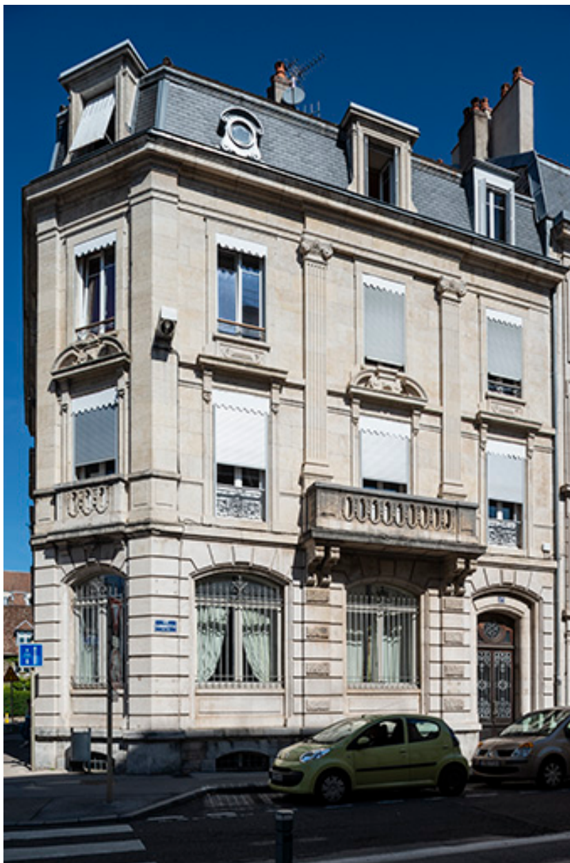
Façade sur la rue Gambetta (n°17).
