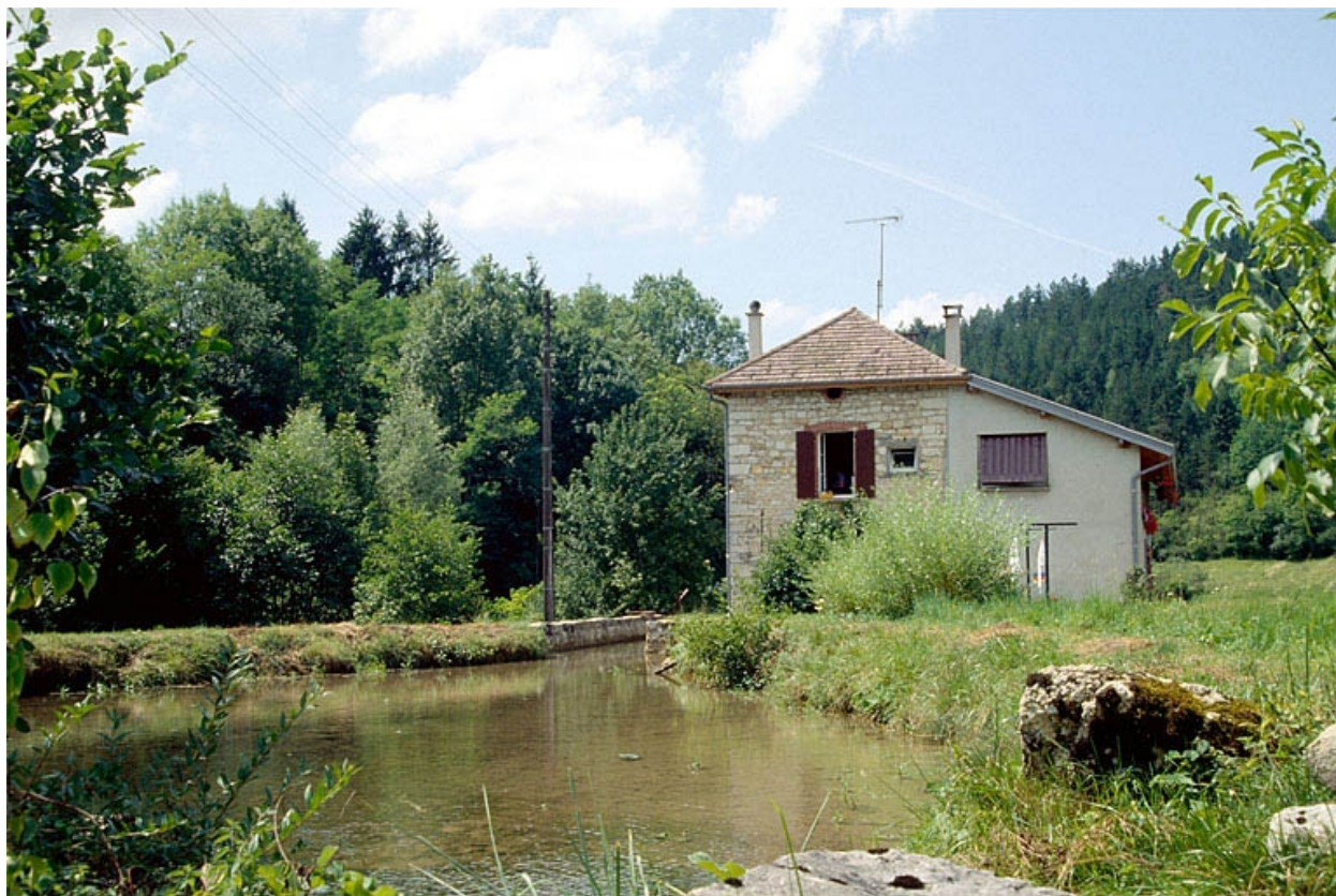
Bassin de retenue et façade latérale gauche.
