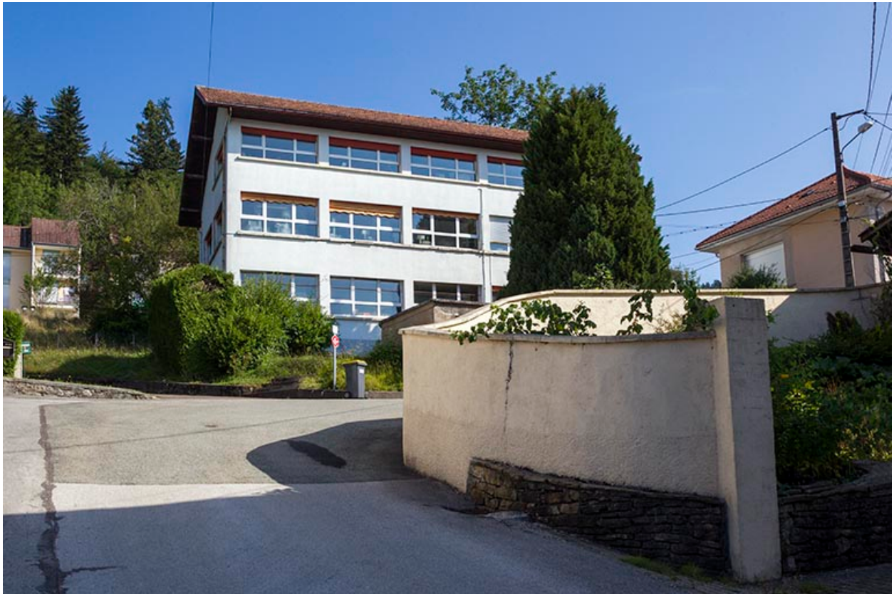
Usine : vue d'ensemble, depuis le sud.
