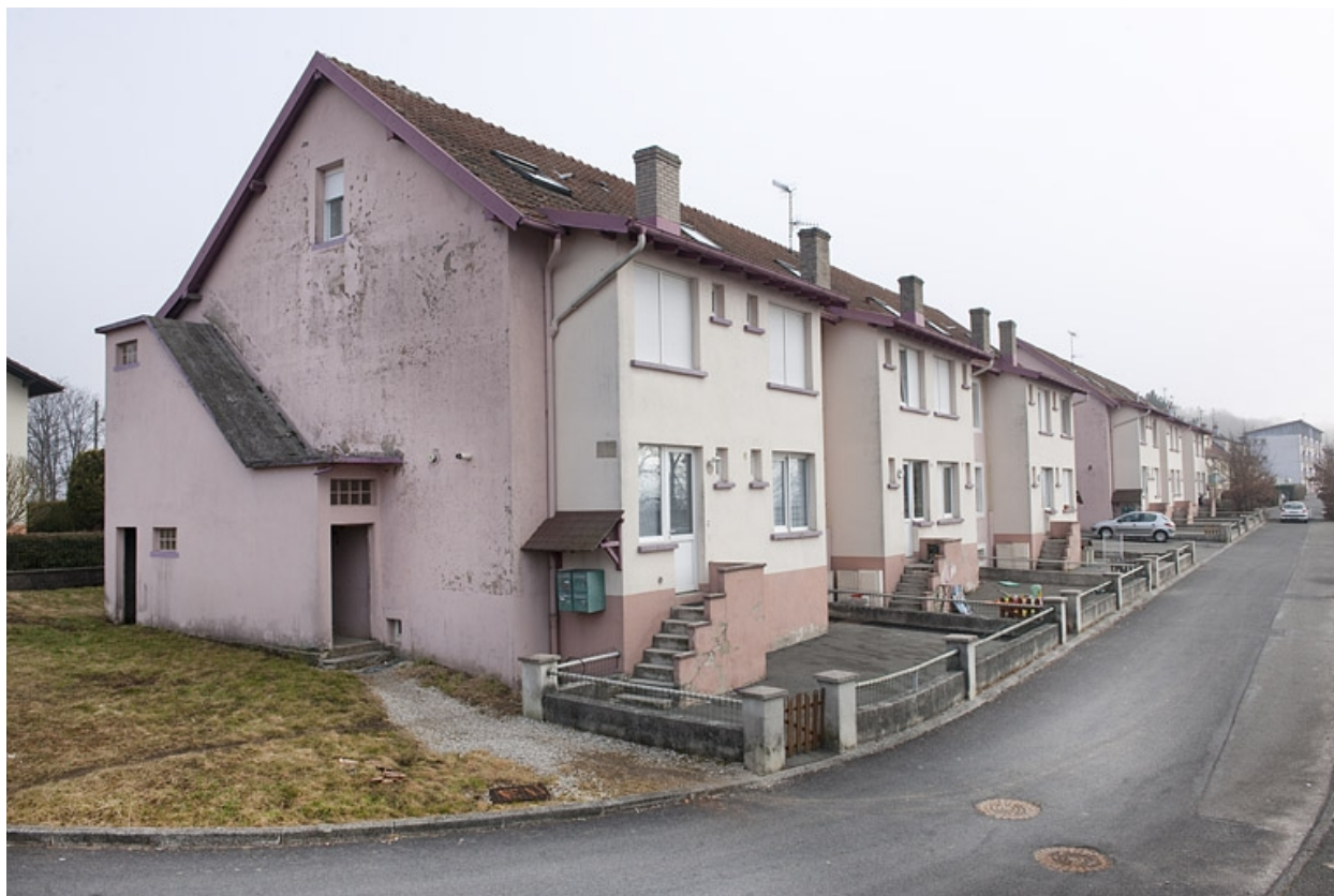
Immeubles d'habitation vus depuis l'ouest.
