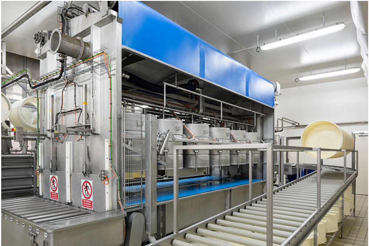
Installation de moulage.
