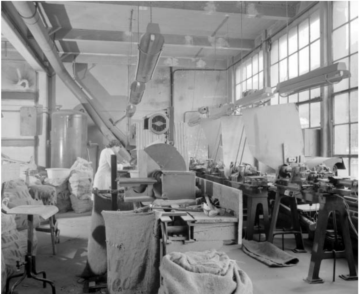
Intérieur de l'atelier d'ébauchage.
